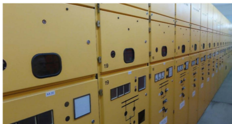
Quelle: Güven NARIN – luftisolierte Mittelspannungsschaltanlage
