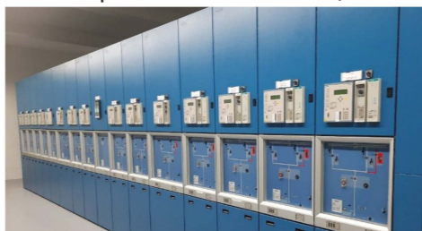
Quelle: Güven NARIN – gasisolierte Mittelspannungsschaltanlage
