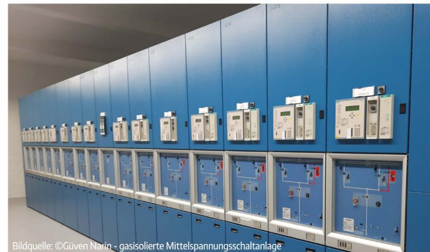
Bildquelle: ©Güven Narin - gasisolierte Mittelspannungsschaltanlage
