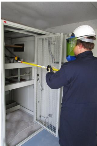
Prüfen des spannungsfreien Zustands / Bildquelle: Franz Swoboda
