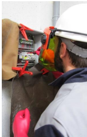
Arbeitsauftrag: Auswechseln eines defekten 3-poligen Sicherungssockels
