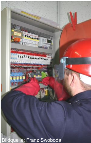
Bildquelle: Franz Swoboda Arbeitsauftrag: Hilfsschütz auswechseln Hier: Aufstecken der Isoliertüllen
